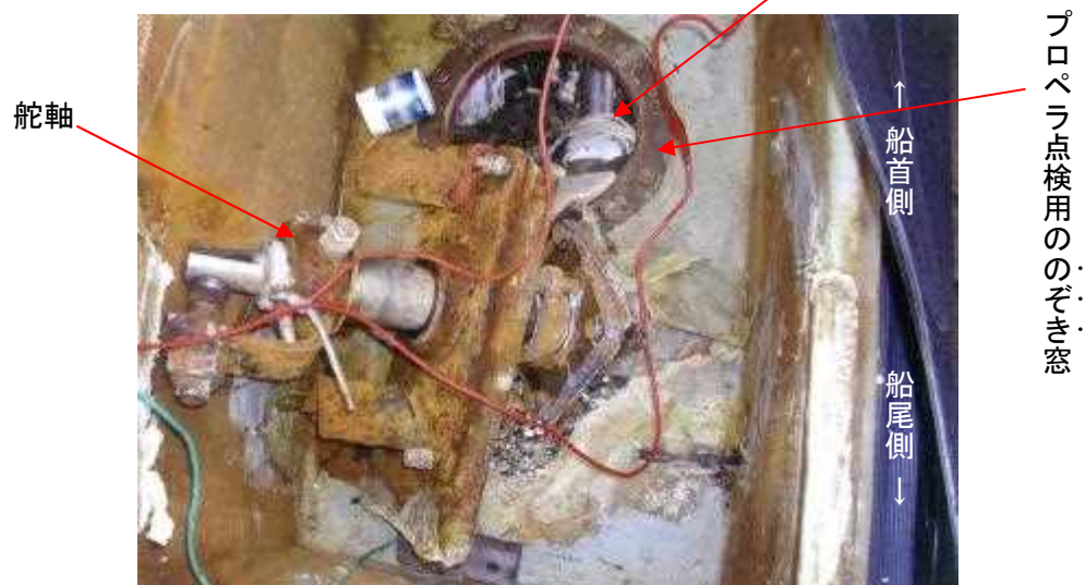
写真3 舵機室内の状況
