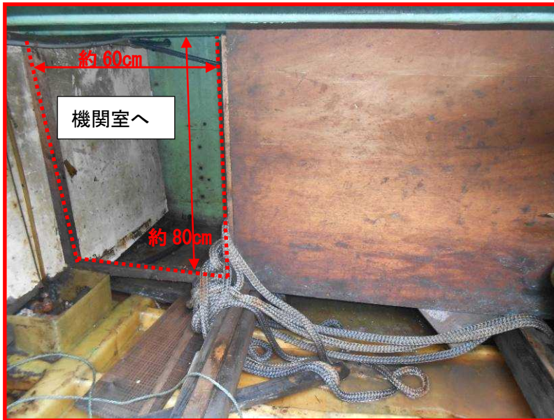
<機関室⇔倉庫間>
