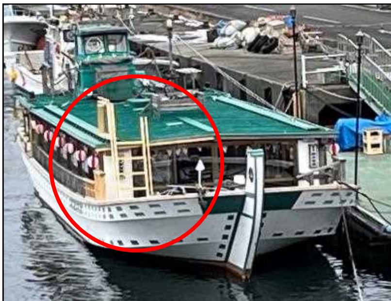
写真3 A船の修理後の状況 ※ 新木材部分が修理箇所
