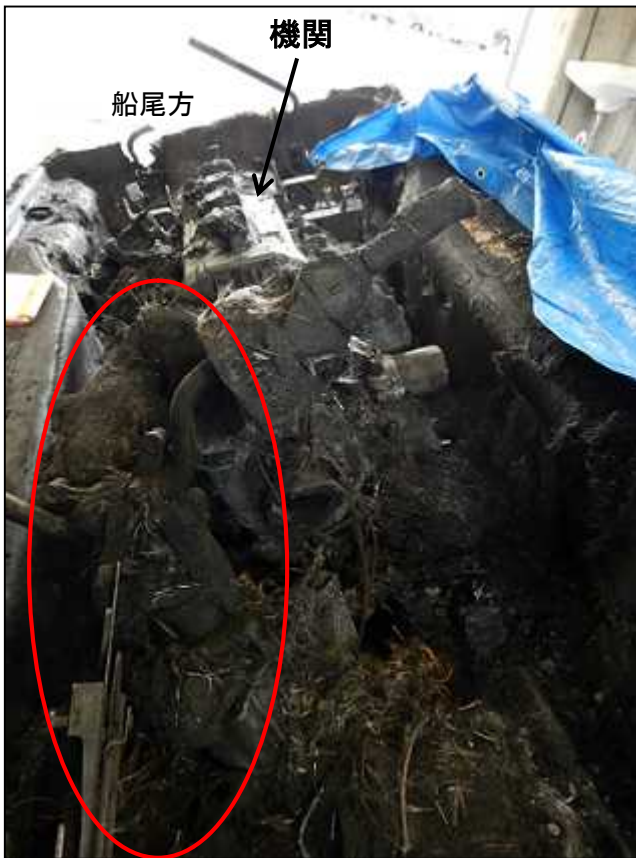
焼損が激しい箇所
