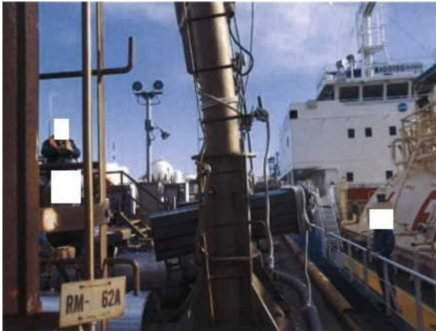
写真4 陸上施設（ローディングアーム）の損傷状況
