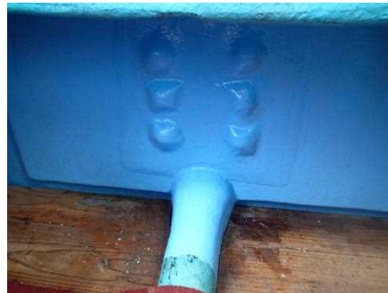
写真4 船体取付部（修繕後）
