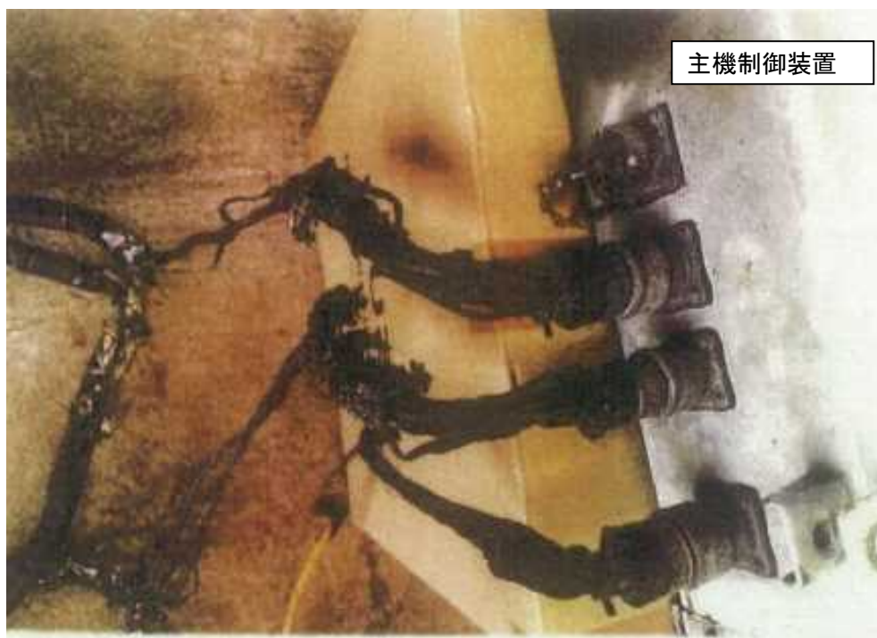
写真 4 主機制御装置外部の状況
