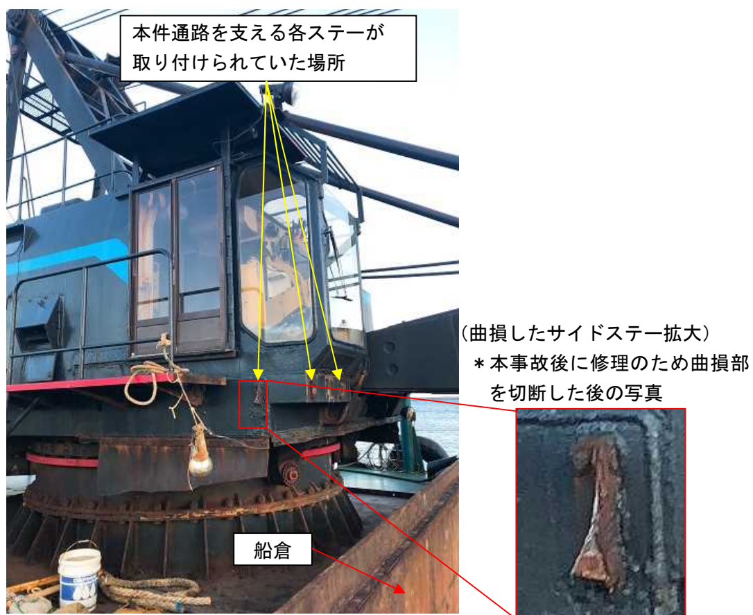
写真2 崩落した本件通路の設置場所
