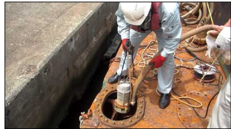
写真4 水中ポンプを空所に下ろす状況（現場調査時）
