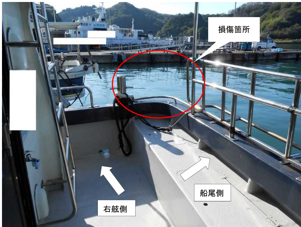
写真3 B船の損傷状況（右舷船尾部）
