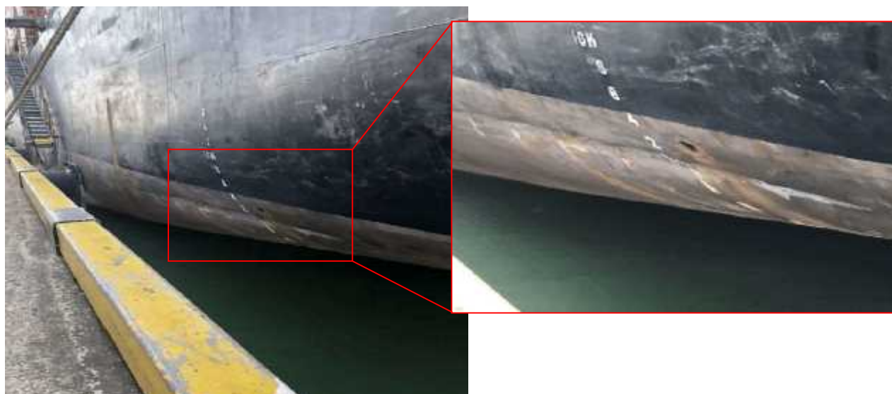
写真1 本船の損傷状況
