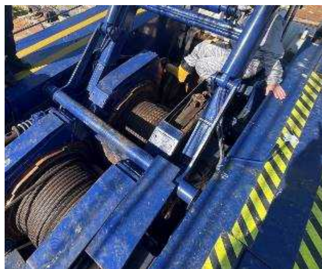
② クレーン正面からの写真
