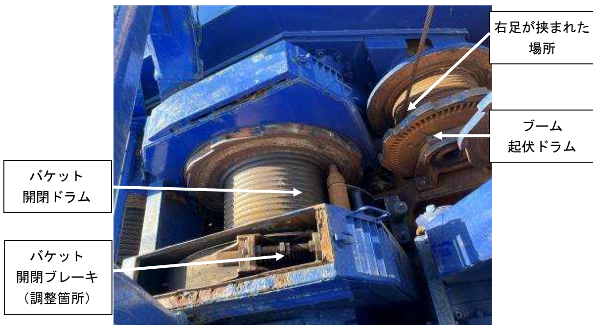
② クレーン左側からの写真
