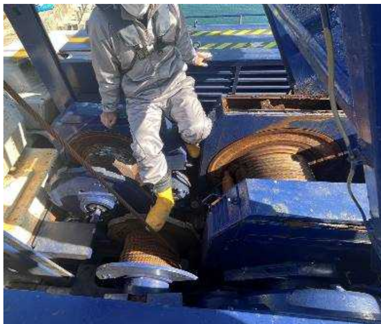
① クレーン右側からの写真
