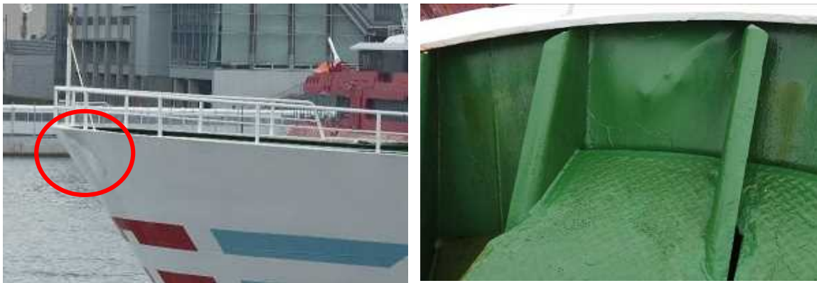
写真3 本船の損傷状況（バウバイザー）
