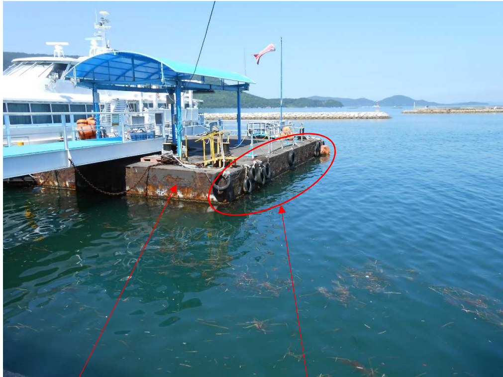
写真3 着棧棧橋の状況
