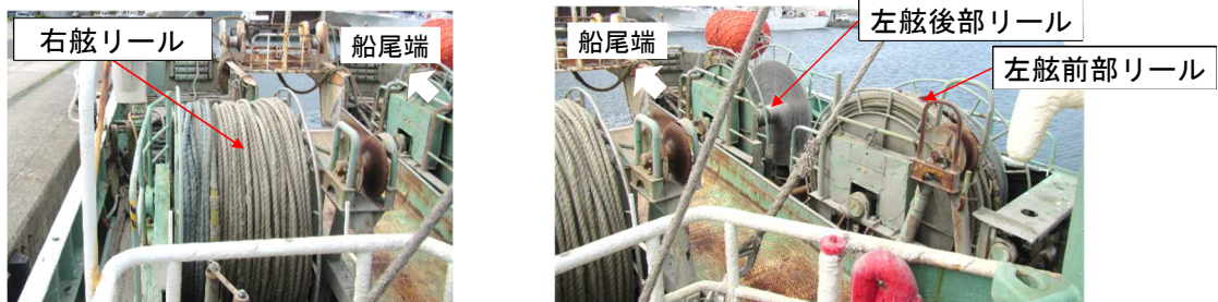
写真2 後部甲板のリール
