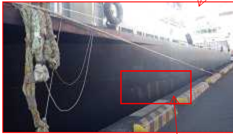
左舷船首部損傷箇所
