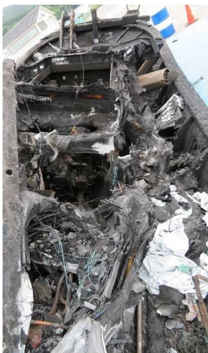
写真5 A船の焼損状況 （上甲板前方）
