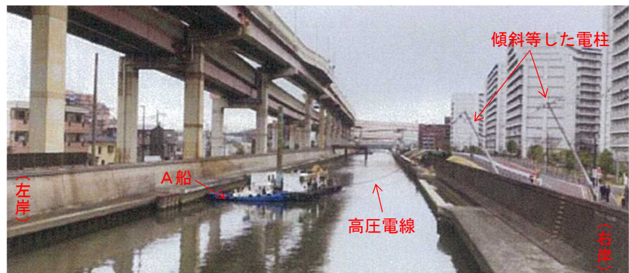
写真2 事故発生時の状況 (B社提供)
