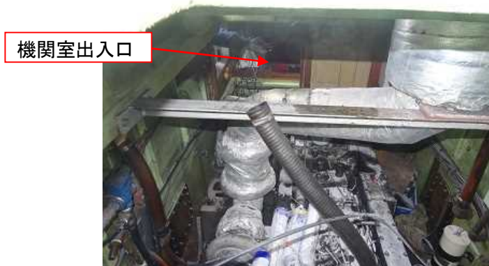
写真2 機関室出入口
