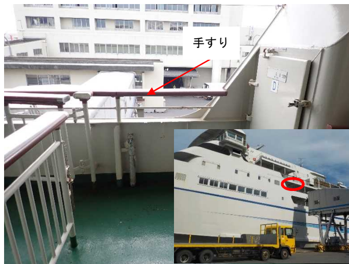
写真3 4階船橋甲板左舷側外通路に設置された手すり等の状況
