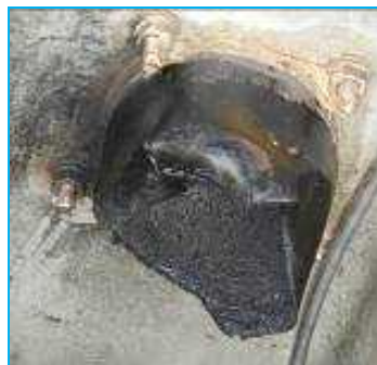
船尾排気管（外板内側）溶損
