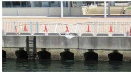
護岸及びハンドレール
