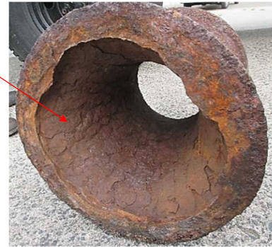
写真9 本件ドラムの破断分離部（破断面）
