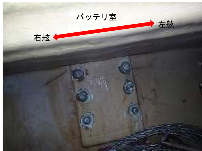
写真3 本船と同型船の本件引揚装置の船内側取付状況
