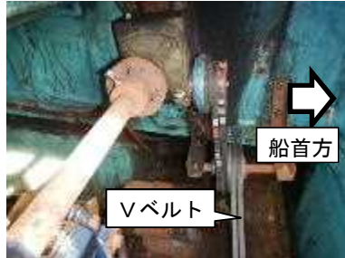
写真2 巻上げ用漁労機設置状況
