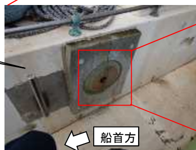
写真4 本件ドラム設置場所
