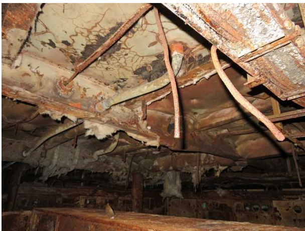
写真7 機関制御室天井
