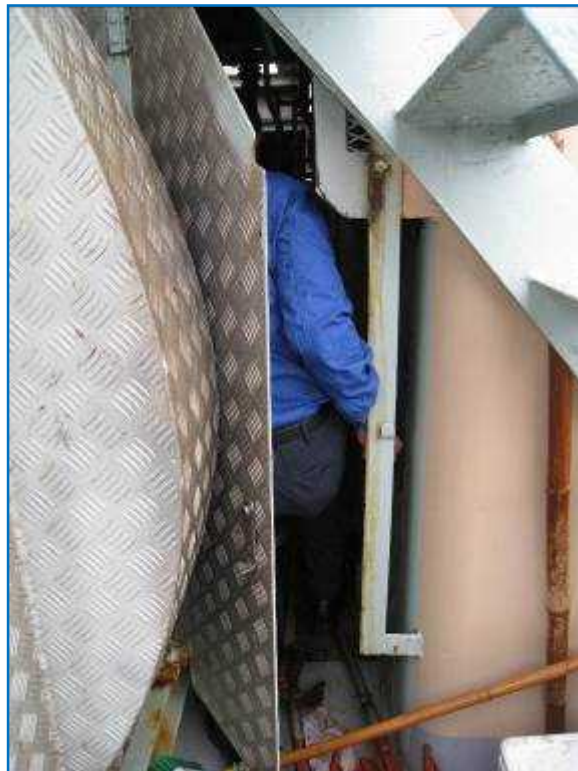
写真2 本件区画の右舷側出入口ドアの付近
