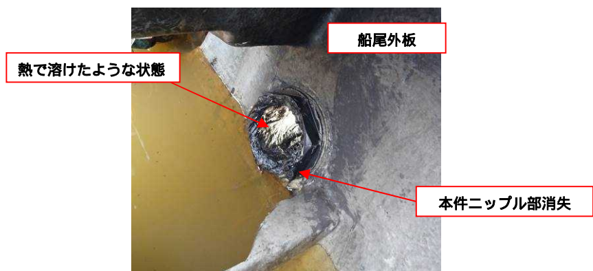
写真3 スル-ハル管入口側（機関室側から撮影）
