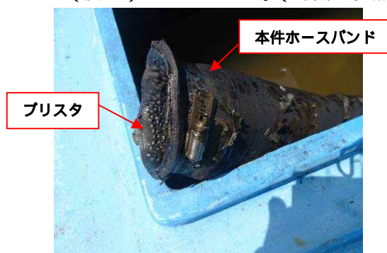
写真4 本件配管出口側
