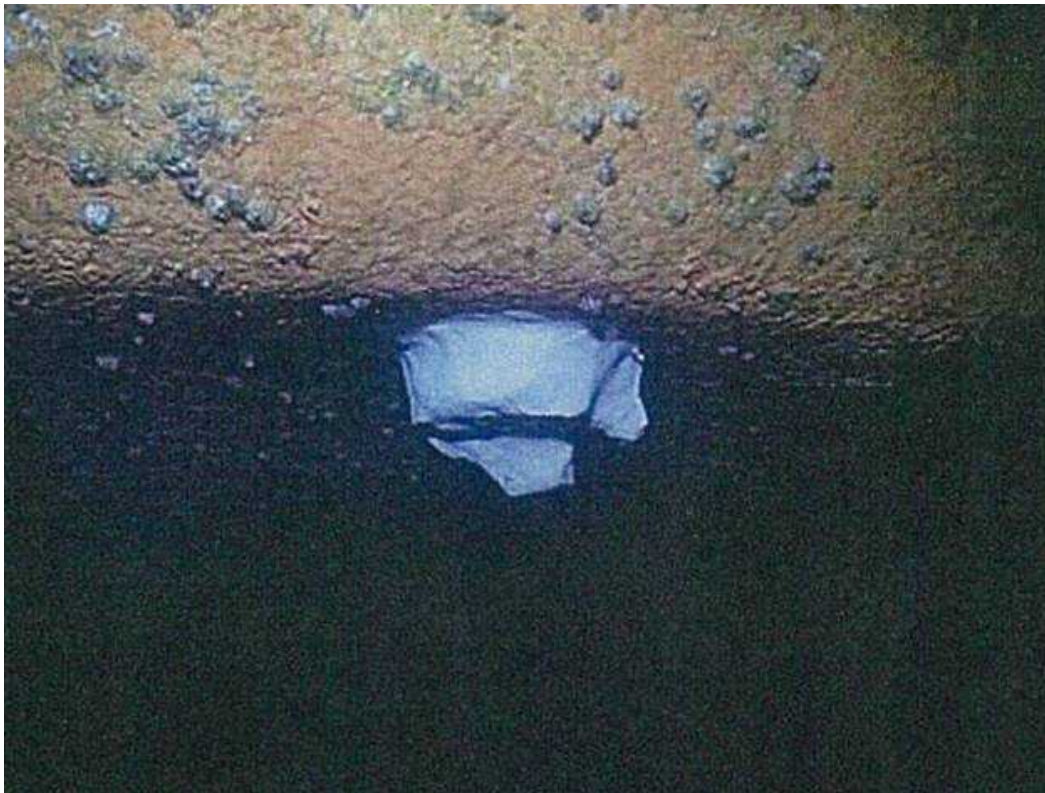
写真2 破口箇所の止水処置状況
