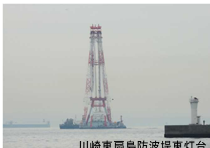
起重機船による引揚げ作業
