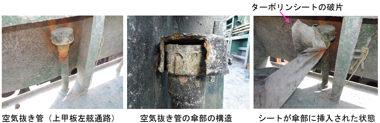
図9 バラスト水タンク空気抜き管の状態
