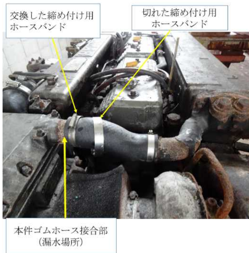
図2 主機の漏水場所付近の状況
