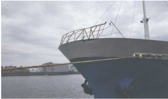
写真1 船首部ブルワークの凹損
