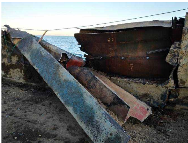
写真5 C船の損傷状況 (2)
