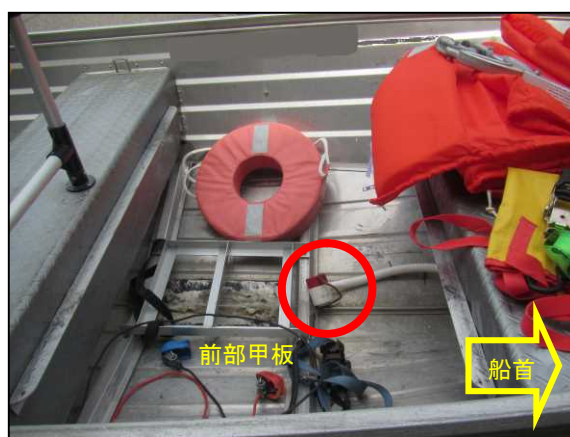
写真3 前部甲板のビルジポンプ
