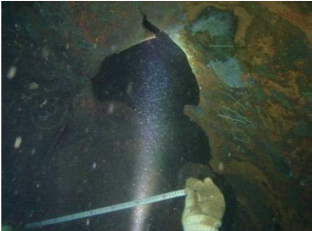
写真3 本船損傷状況（船底部破口）
