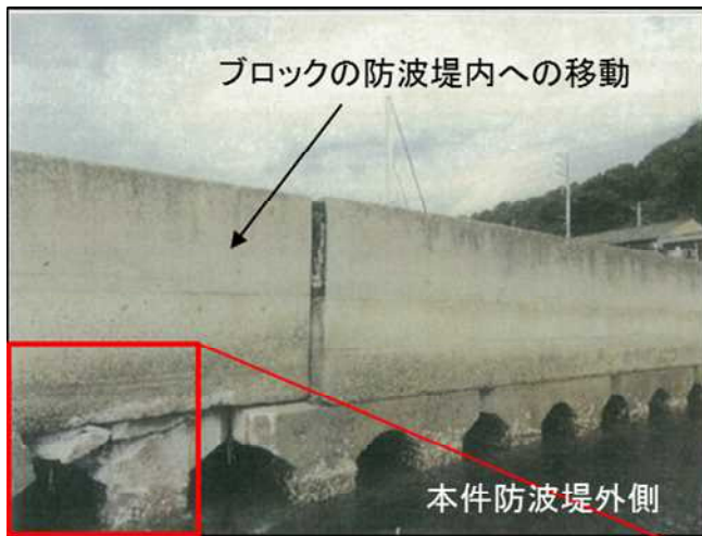
写真2 本件防波堤の損傷状況
