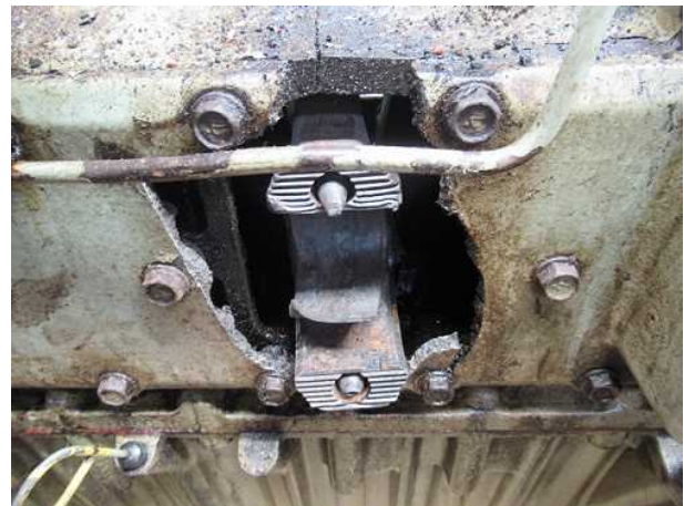
(写真2 / 左舷 / 燃料噴射ポンプ側)
