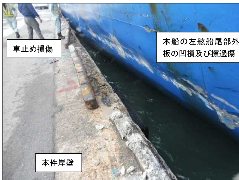
写真4 本船の左舷船尾部外板及び本件岸壁の車止めの損傷
