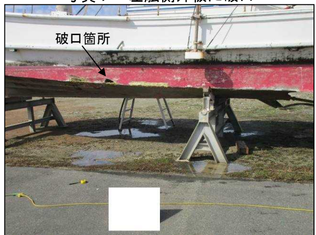
写真7 左舷側外板に破口
