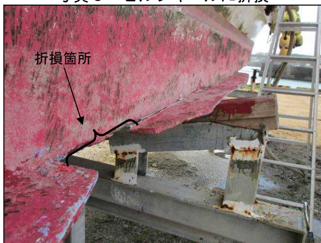
写真6 ビルジキールに折損
