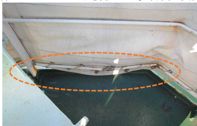
写真2 本船の損傷状況
