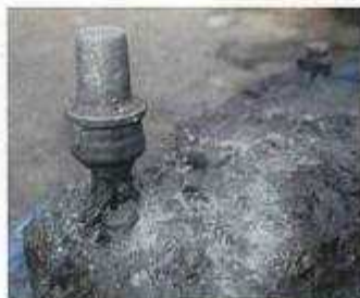
写真9 本件バッテリー (+端子)
