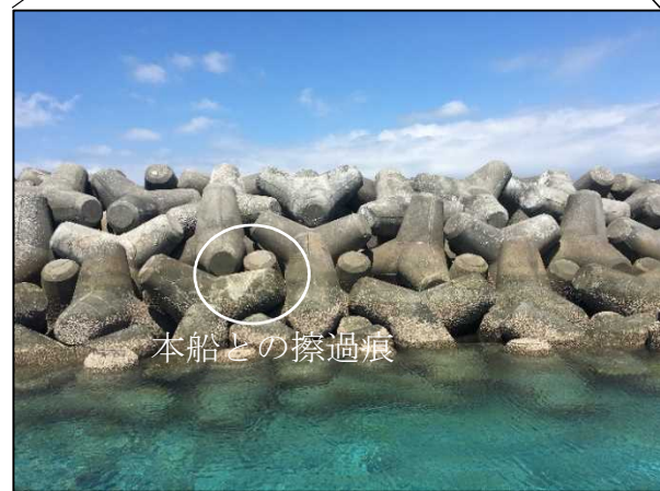
写真2.1-3 本事故発生場所付近の消波ブロックの状況
