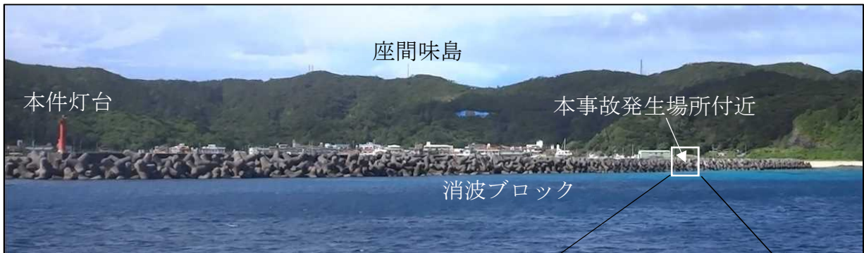
写真2.1-2 本件防波堤（南方から北方を望む）
