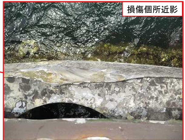
写真3 多々羅大橋2P橋脚南西面の緩衝工の損傷状況
