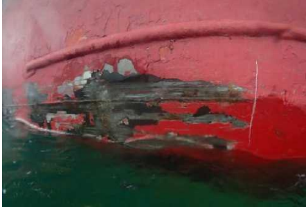
右舷船首部外板に凹損
