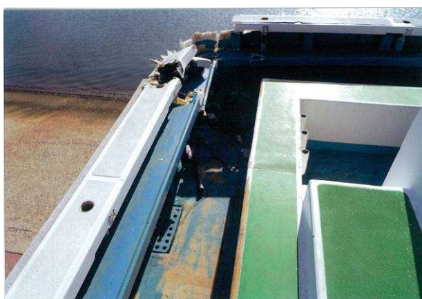
写真3 A船の損傷状況（右舷船尾部外板）
