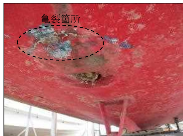
写真2 船底外板に亀裂
