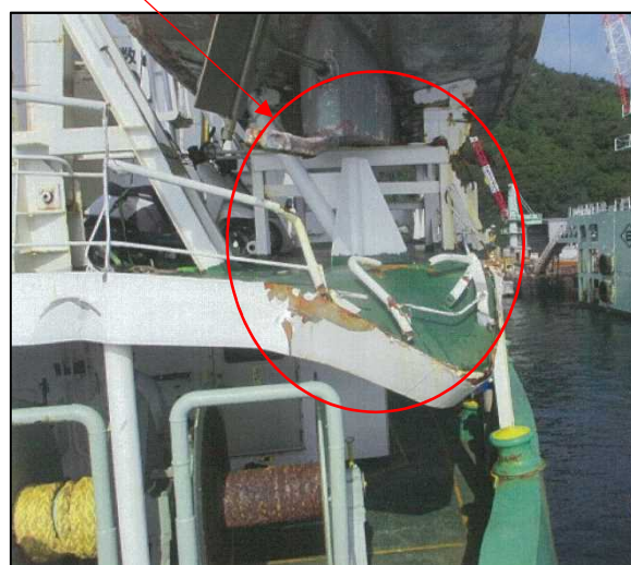
写真6 B船の損傷状況 (右舷船尾部甲板及びハンドレール)
