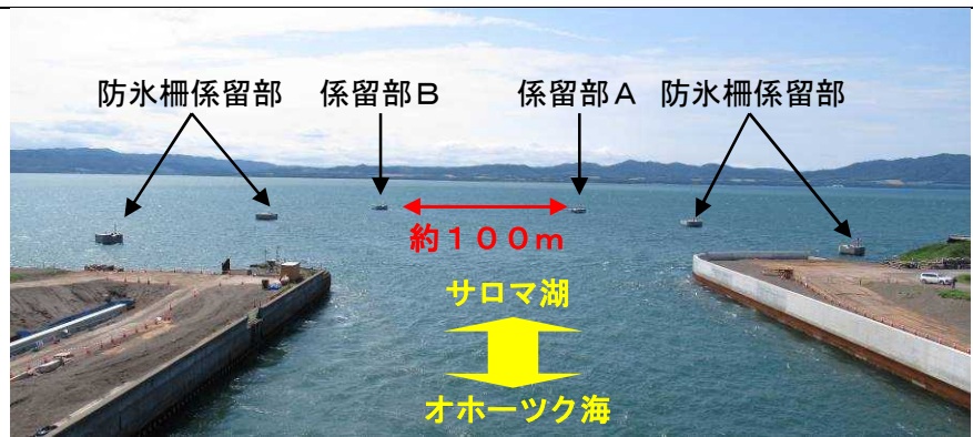
図1 第2湖口から見る防氷柵係留部設置状況
