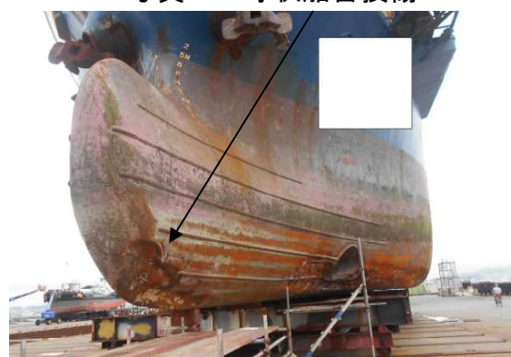
写真2 球状船首損傷
