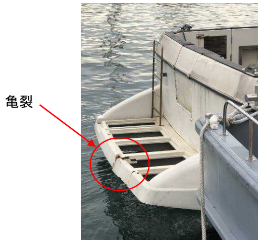
写真1 B船の船尾トランサム亀裂状況
